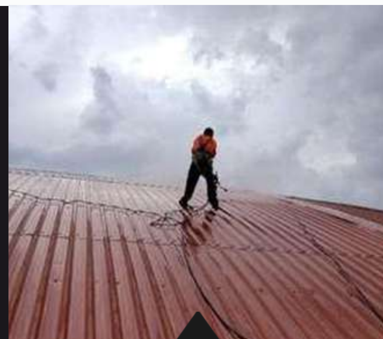
Rehabilitación y eficiencia energética de edificios
