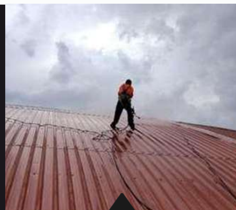
Rehabilitación y eficiencia energética de edificios
